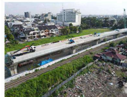
Pekerjaan Parapet P4-P5
