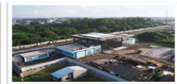
Pekerjaan Bangunan Stasiun Helvetia
