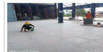
Pekerjaan Arsitektur Stasiun Helvetia
