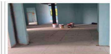
Pekerjaan Arsitektur Stasiun Helvetia
