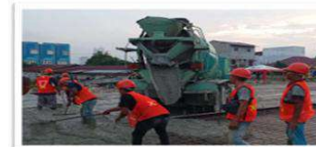
Pekerjaan Landscape Stasiun Helvetia
