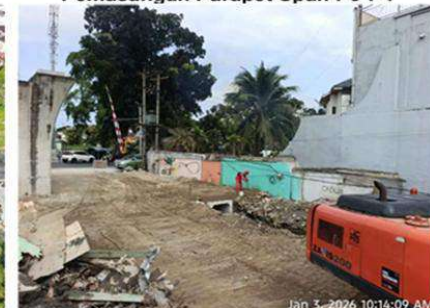
Pekerjaan Timbunan Dan Pemasatan P9bj-P0
