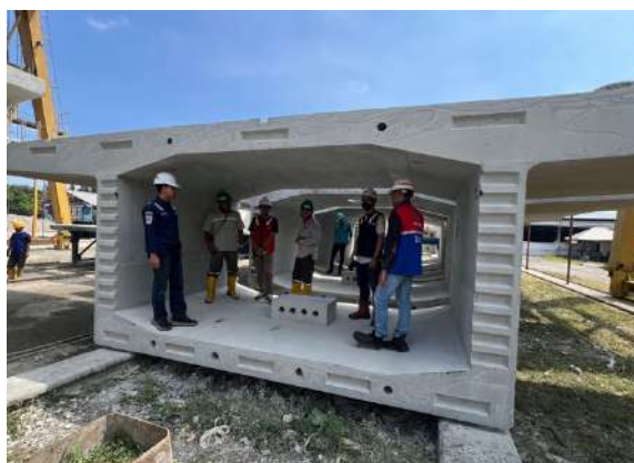
Gambar 2. 4 Dokumentasi Progress Kegiatan Pembangunan JLKAMB
