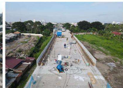
Pemasangan Parapet Span P3-P4
