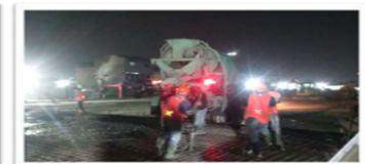
Pekerjaan Landscape Stasiun Helvetia
