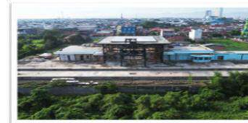
Pekerjaan Bangunan Stasiun Helvetia
